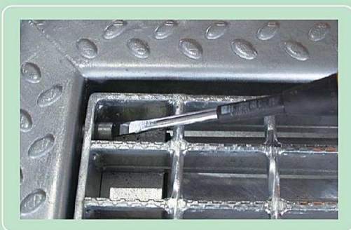
マイナスドライバーにて回しながら収納させている ストップピンを出します。(左右とも)
