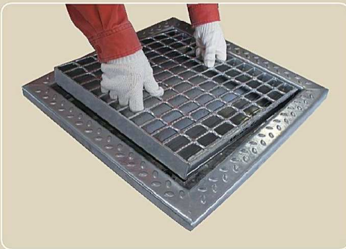
グレーチング本体を設置します。
