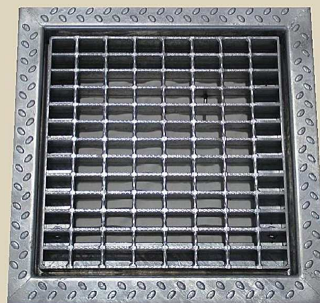
落とし込みタイプの完成です。
