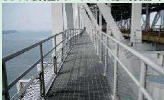
SGめっき再生グレーチングの施工例(瀬戸大橋)
