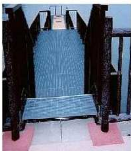
山口県笠戸島 海上棧橋 (2001年3月施工)
