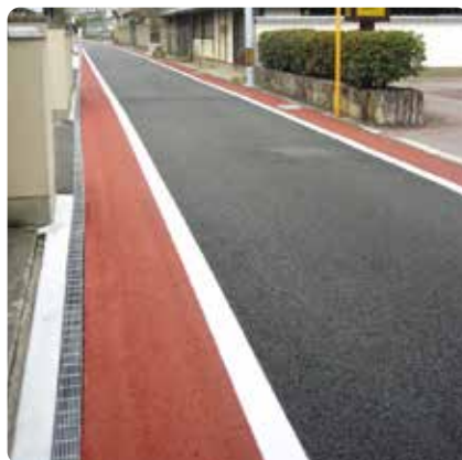
TA-120W(本体TA-5NS)(D) 排水性舗装用(岡山県)
