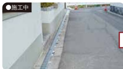
TA-5NS (H-50用) 岡山県内での施工例です。
