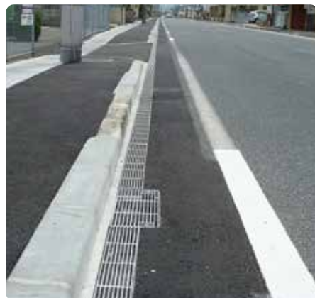
TA-7NSW(N) 普通舗装用(H-120用) (鳥取県)
