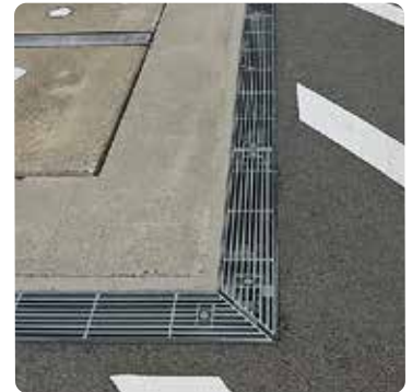
接続例 (徳島県)
