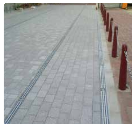
TAJ-2YC(N)+TAJ-3YC(N) 普通舗装用 カラーYバー (愛媛県)
