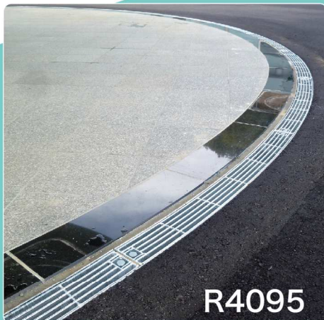
TAJ-4NS(D) 排水性舗装用(H-90用) R用ドレンゲッター (愛知県)
