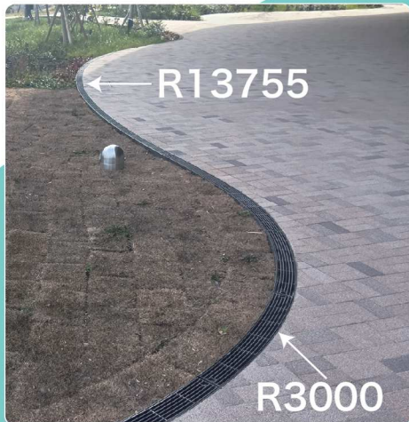
TAJFJ-5NS-10W250H ケンボーピング R用ドレンゲッター(千葉県)
