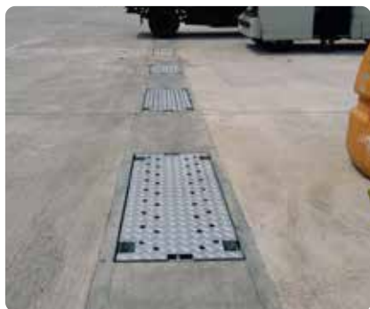
かさ上げグレーチング 全面張りタイプ+ボルト固定式
