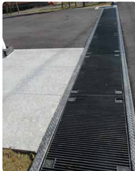
ケンボーリングボルト固定 (Zアングル)
