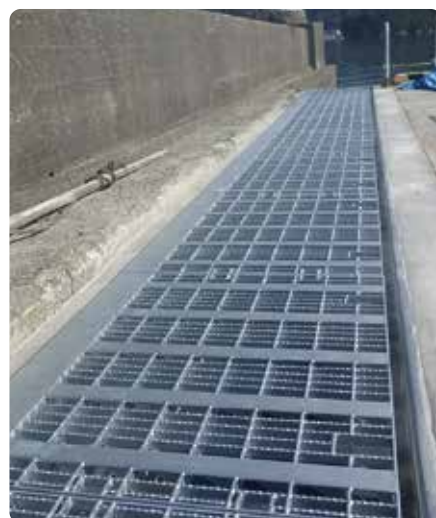
三重県 2016年施工
