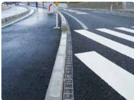
TAJ-5NS(D) 排水性舗装用(H-50用) (鳥取県)
