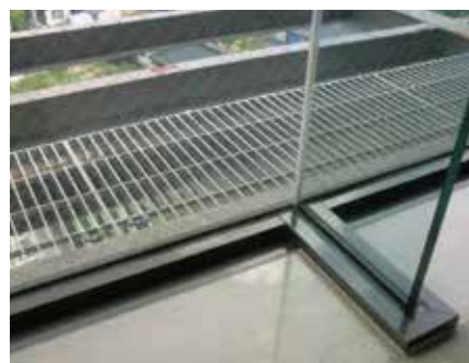
施設点検足場
