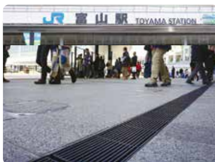
TAJ-12NSW (N) 普通舗装用 (H-100用) ケンボーピングめっき (富山県)
