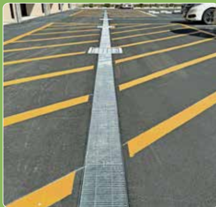
TADFPH-200W 300H-B(D) 排水性舗装用 (兵庫県)
