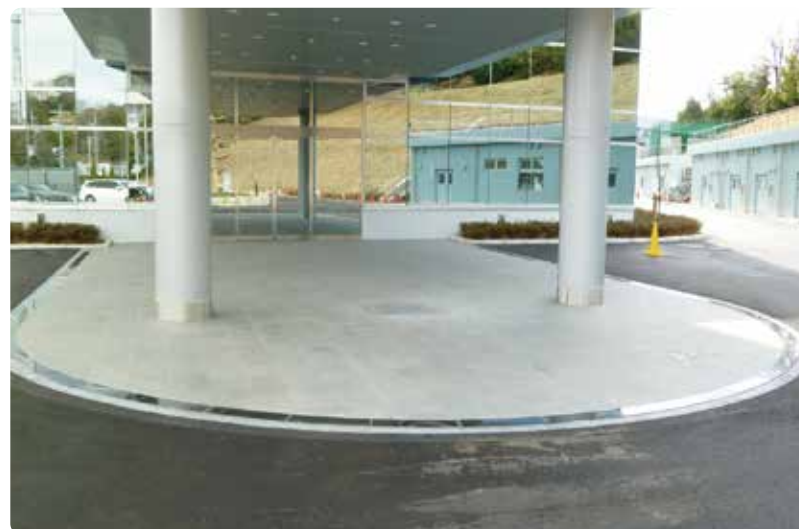
TAJ-4NS(D) 排水性舗装用(H-90用) R用ドレンゲッター (愛知県)
