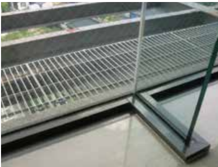
施設点検足場
