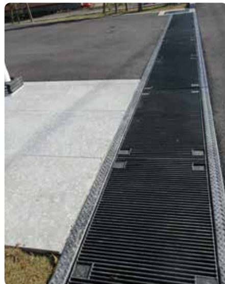
ケンボージングボルト固定 (Zアングル)
