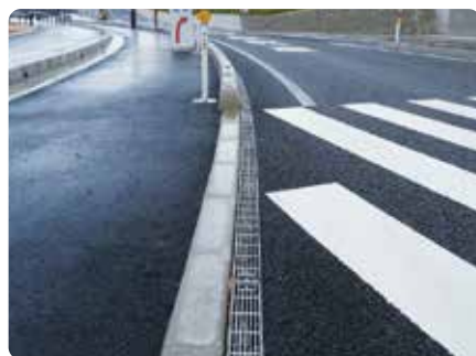
TAJ-5NS(D) 排水性舗装用(H-50用)(鳥取県)
