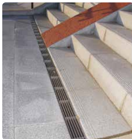
TA-4NS (N) ステンレス製 普通舗装用 (H-90用) (広島県)
