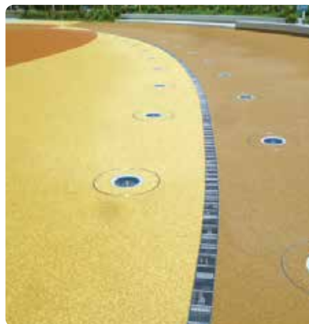
ステンレス製 U字溝用 300用 (静岡県)
